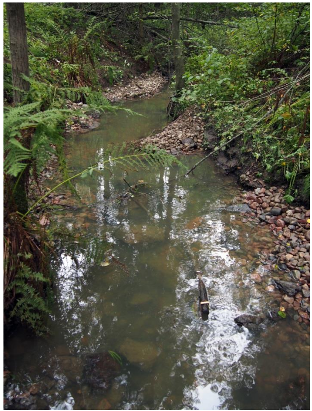
Alue 1. Virta-alueen keskiosaan rakennettiin kaksi soraikkoo (vas.) ja niska-alueen uomaa kavennettiin suisteilla, jotka myös keräävät kiintoainesta (oik.).
