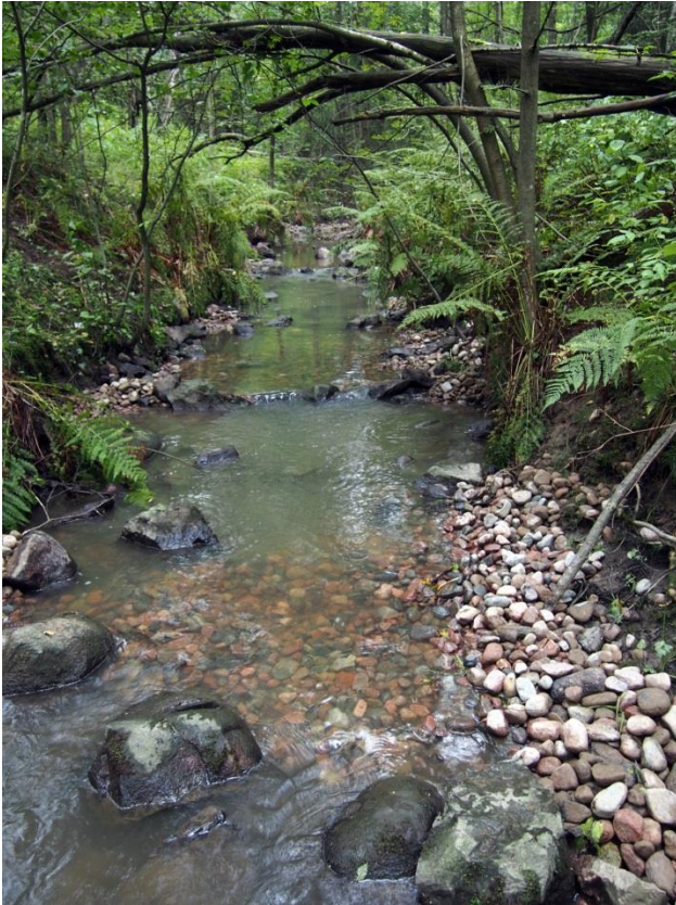
Alue 1. Virta-alueen keskiosaan rakennettiin kaksi soraikkoo (vas.) ja niska-alueen uomaa kavennettiin suisteilla, jotka myös keräävät kiintoainesta (oik.).
